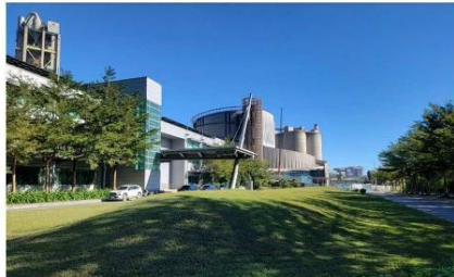
台泥大樓-汽化爐(建物右方)
