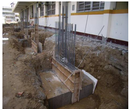
施工中(預設為「鋼筋綁紮」階段)
