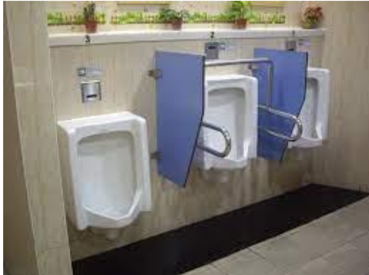
廁所盥洗室-一般廁所無障礙小便器
