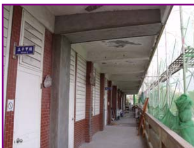
梁、柱表面修飾處理
