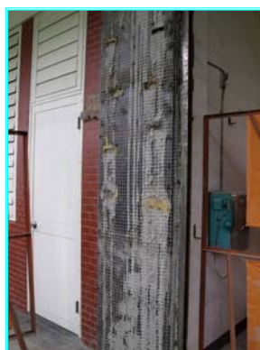
鋼板外鋪設鋼絲網
