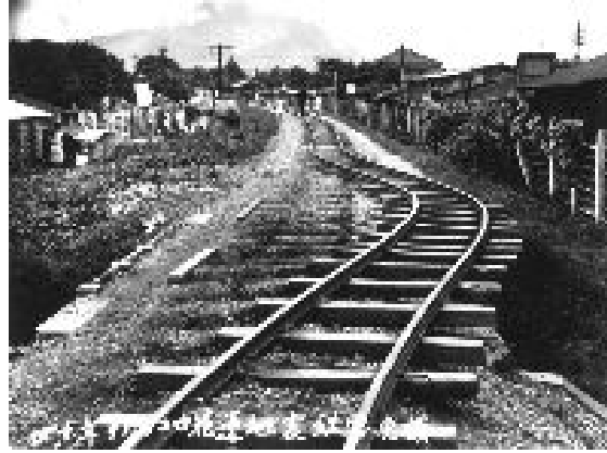
花蓮市中華路鐵路彎曲受損，最大位移量為250公分
