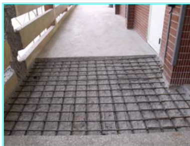
樓版綁紮鋼筋
