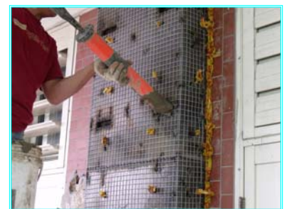
灌注水泥砂漿 於鋼板與柱體間
