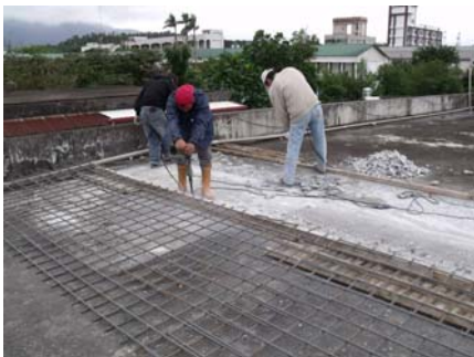
樓板打除，置入鋼筋網
