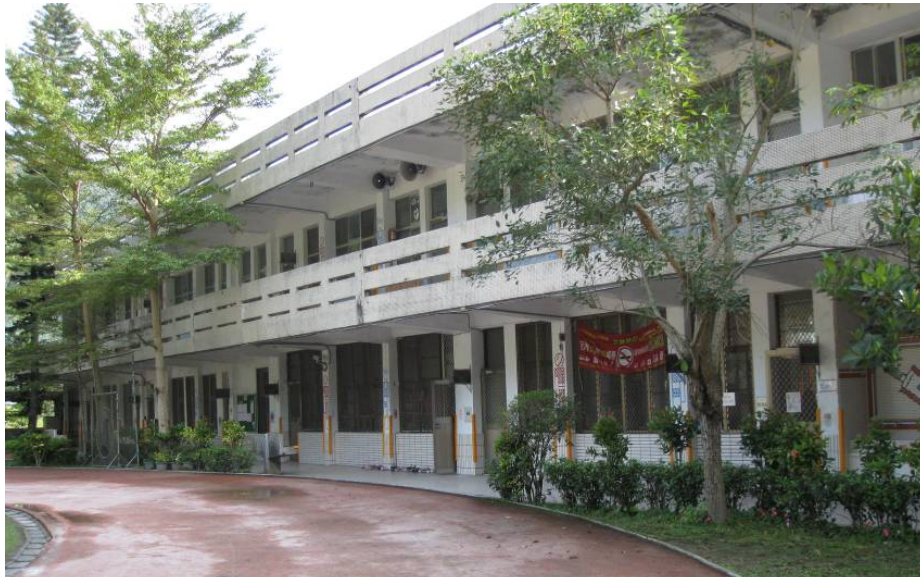
行政大樓 將採翼牆補強
