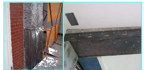
梁、柱包覆鋼板
