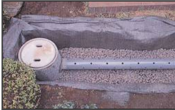
圖 3-21 滲透排水管實例
