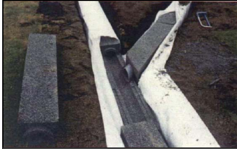
圖 3-10 滲透側溝、渠實例
