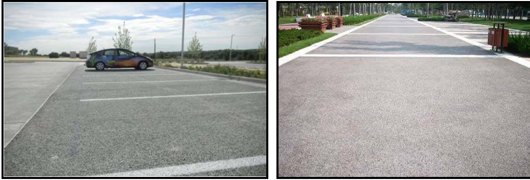
圖 3-27 透水混凝土鋪面案例
