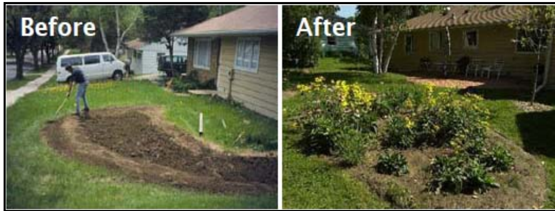
圖 2-5 雨花園施作前(左圖)與施作後(右圖)之成果
