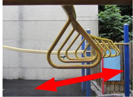
二、從設備使用方向性(箭頭)判斷，連續性使用的吊環，設備雖會晃動但屬於上肢體設備，是允許設置的
