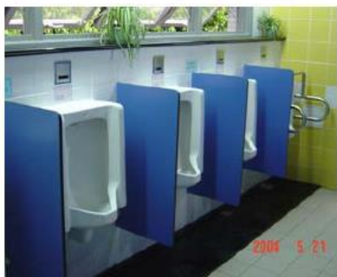
圖 3-32 小便器下方應設置腳踏鋪面
