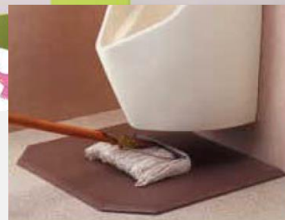
圖 3-26 小便器下方之清掃空間
