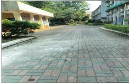
圖八：舊有無障礙坡道周圍步道狀況。
