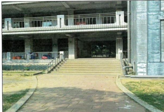
圖一：和平樓中央通道處階梯。
