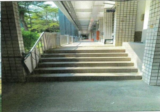
圖二：和平樓東側出口階梯。
