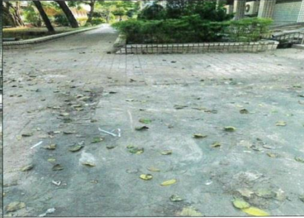
圖七：舊有無障礙坡道緩衝帶地面狀況。
