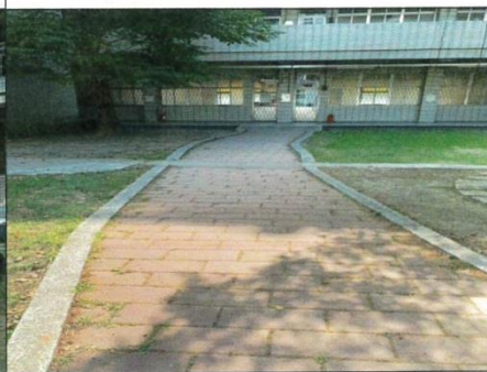
圖十：和平樓通往仁愛樓步道狀況。
