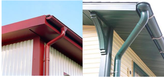
包邊、新設排水管
